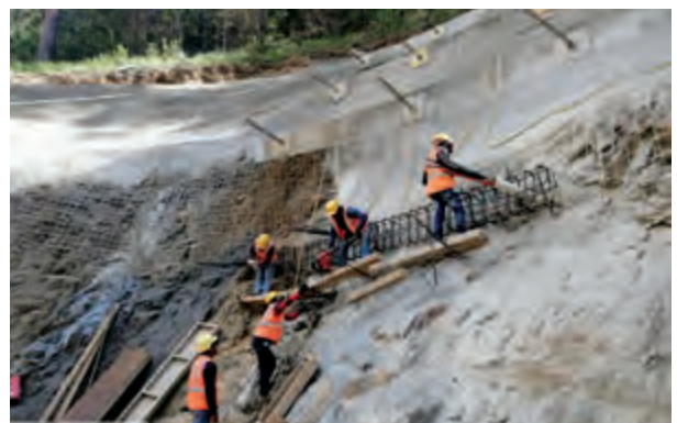
FIGURA 5. Estabilización del portal norte del túnel San Sebastián.
