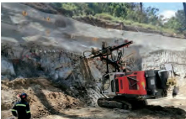
FIGURA 4. Portal norte del túnel San Sebastián.
